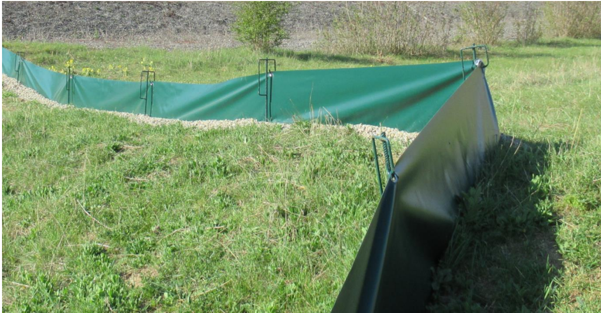
Abbildung 3: Korrekt aufgestellter Reptilienzaun mit glatter Oberfläche (Abbildung FABION).
