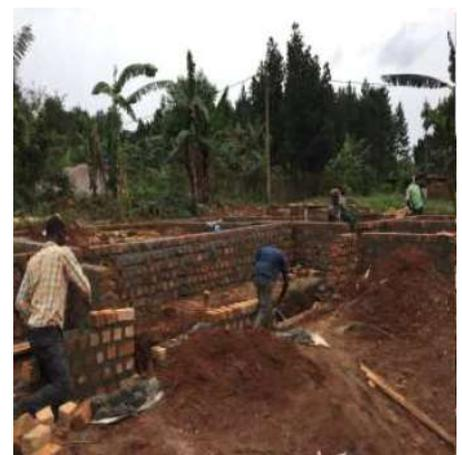
Beton wurde dann auf den Kern gegossen, um ein festes und ebenes Fundament für die Sockelwand zu schaffen. Es entwickelt eine ausreichende Druckfestigkeit, wenn es aushärtet, um die Last auf Fundamenten zu tragen. Gebäude der Sockelwand, dies ist der Teil des Gebäudes, der den Oberbau und den Unterbau trennt. Seine Hauptanwendung besteht darin, eine ebene Oberfläche für Mauerwerksarbeiten bereitzustellen.
