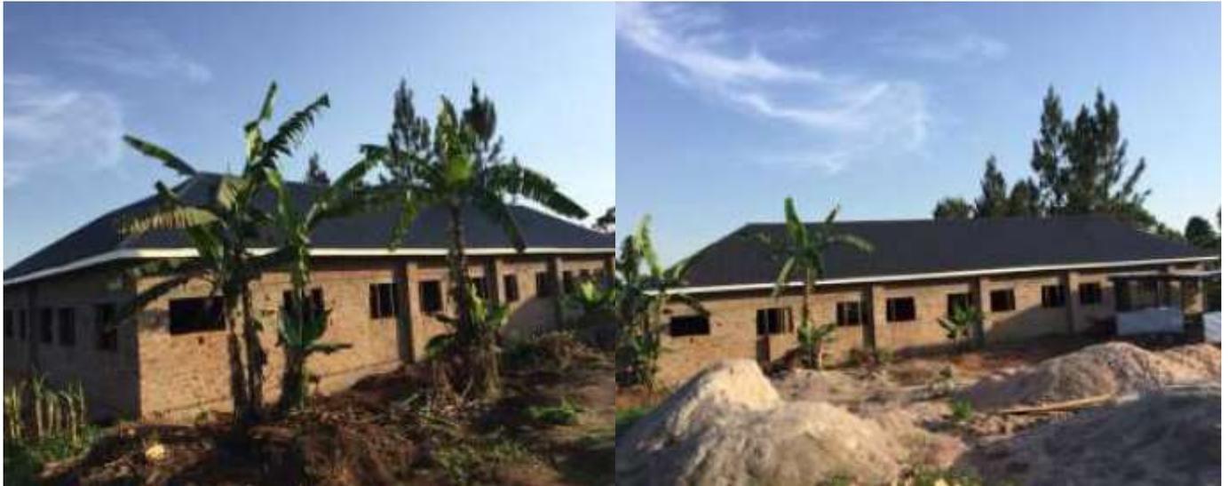
Die Baustelle ist für einen Kindergarten im Dorf Kagala, Division Goma, Mukono Municipal Council. Die durchgeführten Arbeiten umfassten Baufeldräumung, Absteckung, Aushub für Fundamentgräben, Betonieren der Streifenfundamente für den Unterbau, Blockbau, Gießen von Ringbalken, Bedachung des Überbaus. Das folgende ist eine Zusammenfassung der Aktivitäten, die vor Ort für den Zeitraum von zwei Monaten durchgeführt wurden.
